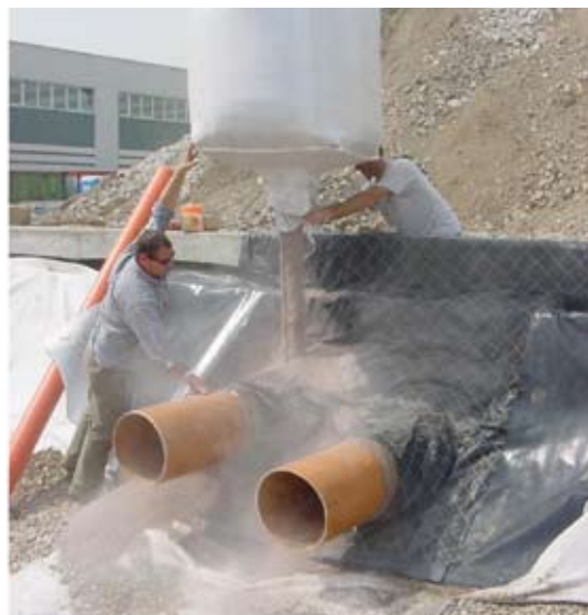
In queste pagine alcune fasi dei lavori nella ex area Autobianchi di Desio
