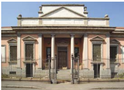
La facciata della sede istituzionale
